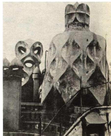
А. Гауди. Дом Мила, дымоходы и вентиляционные шахты на крыше. 1905—1910.
